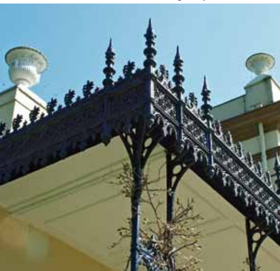
Detail veranda commandantswoning, 2009
